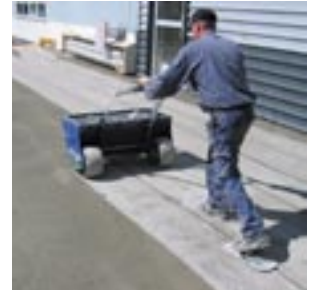
Utläggning av Mastertop med ny strövägn från Modern Betong
