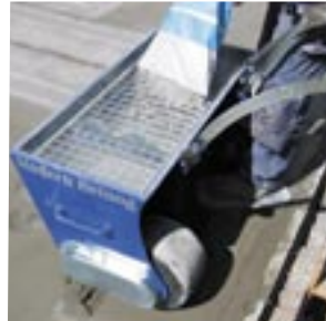
Utläggning av Mastertop med ny strövägn från Modern Betong
