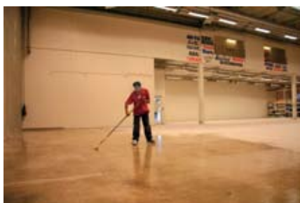
Ytan grundas med primer
