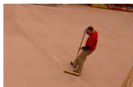
Mastertop 1250 avjämningsmassa läggs ut
